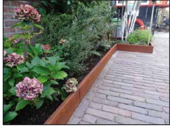
Borderranden van cortenstaal
